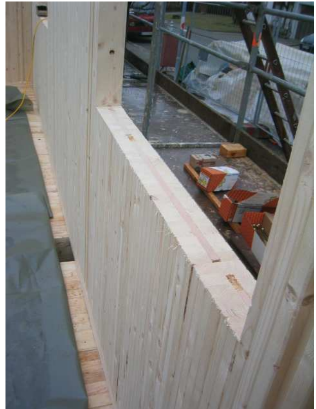
Die sichtbaren Buchen-Hartholzdübel
